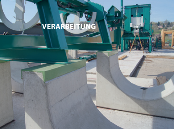
Der Sortierblockzug wird bei der Firma Rahner auf die Rundholzboxen montiert
